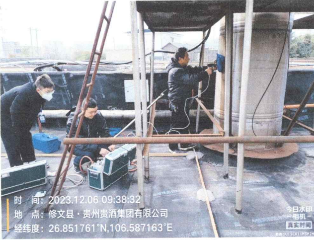
锅炉烟囱废气排放口
